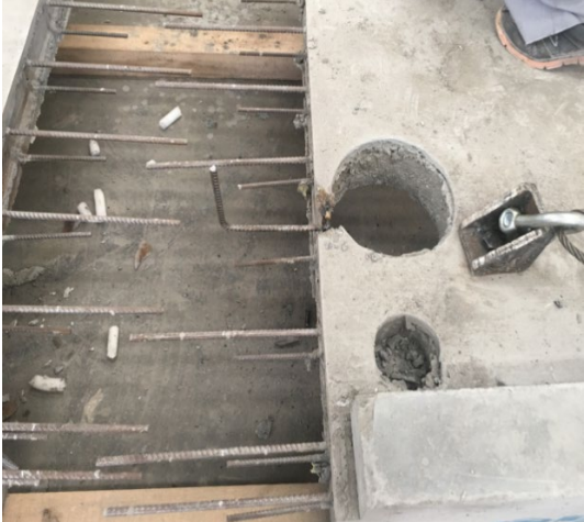
洞口钢筋需要焊接处理
