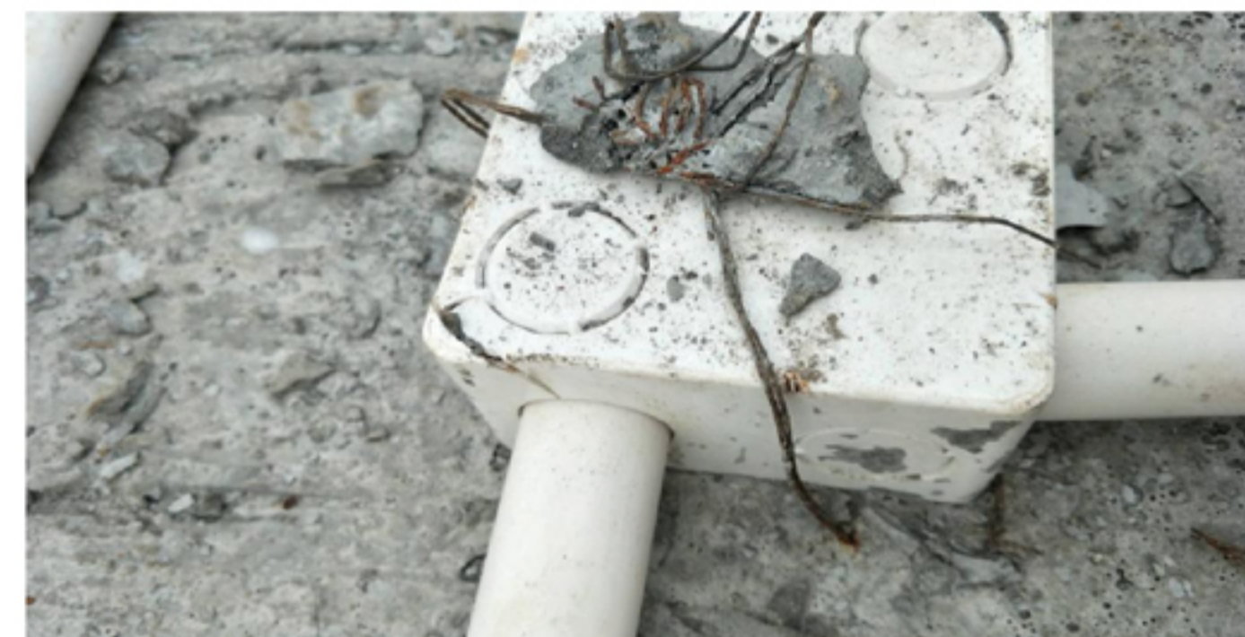
图5 某项目叠合板上的预埋线盒配管
