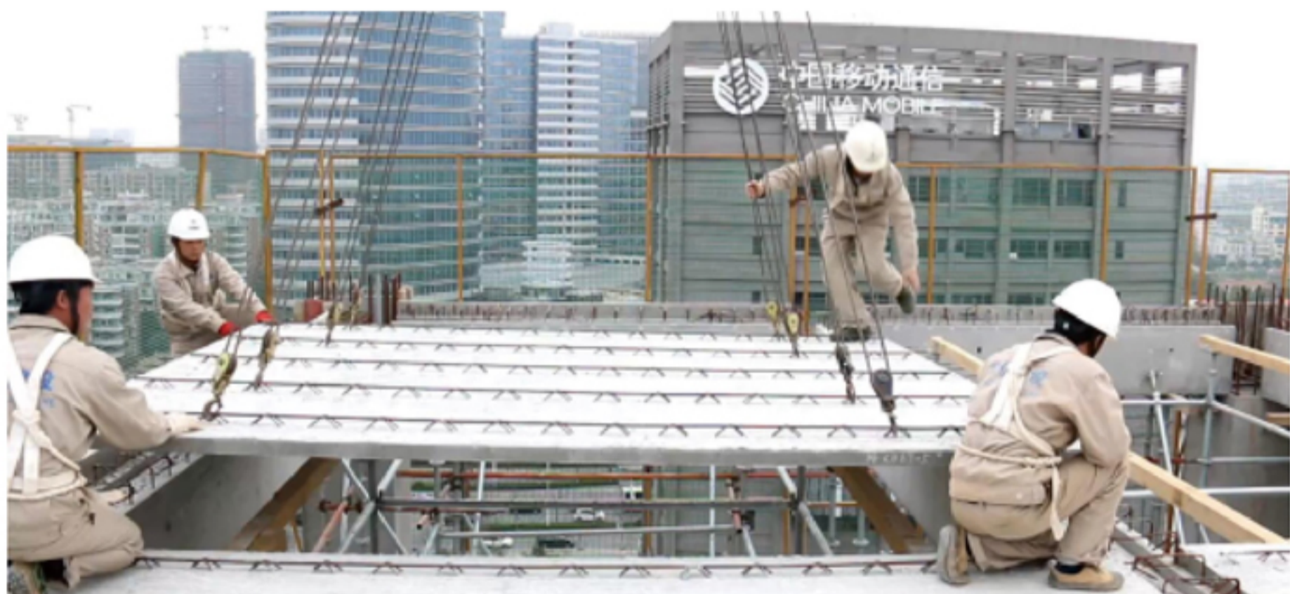
图7 某项目叠合板吊装
