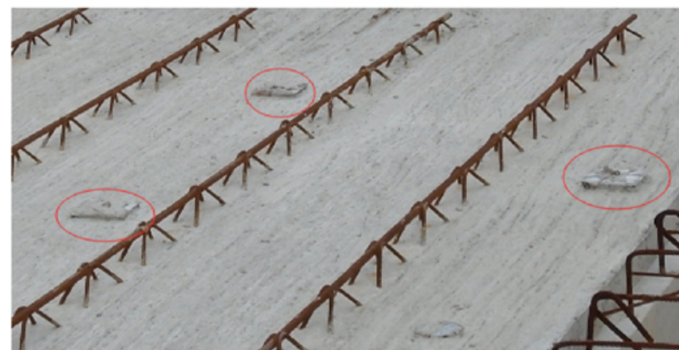
图6 某项目叠合板线盒预埋
