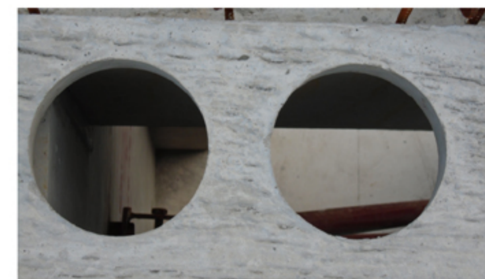
图9 某项目叠合板吊装后的预留洞
