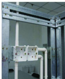
附图四 装配化管线的CSI系统安装
