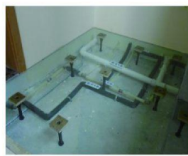
附图二 装配化同层管路安装
