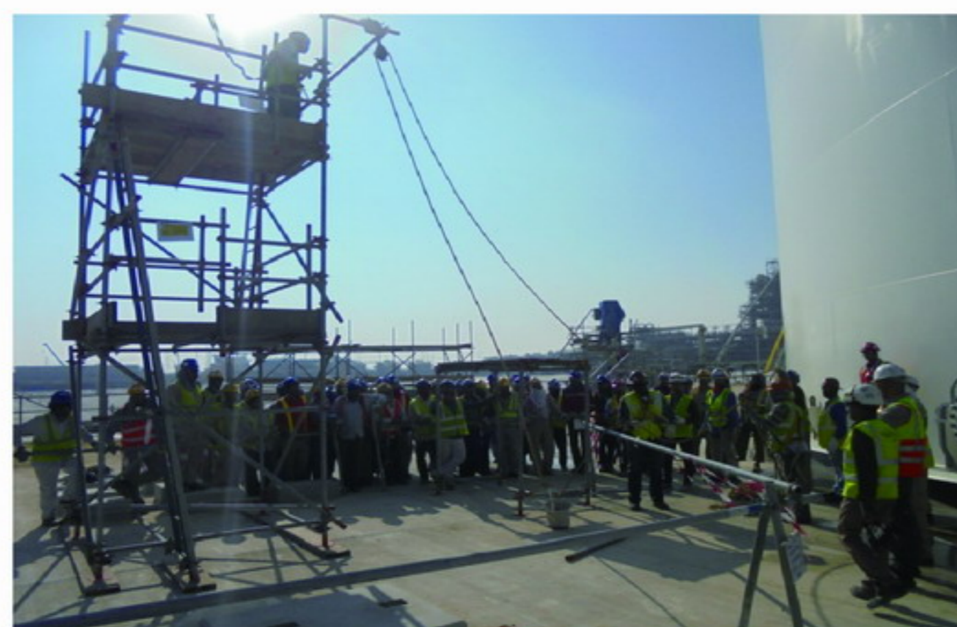
(脚手架人员再培训，搭拆脚手架时四周做好围挡，用吊篮传物件，作业人员穿戴好安全带)
