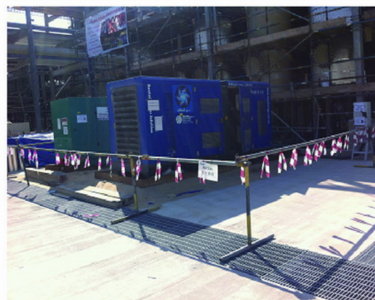
(发电机下面设置接油盆,做好围挡,并挂上警示牌)
