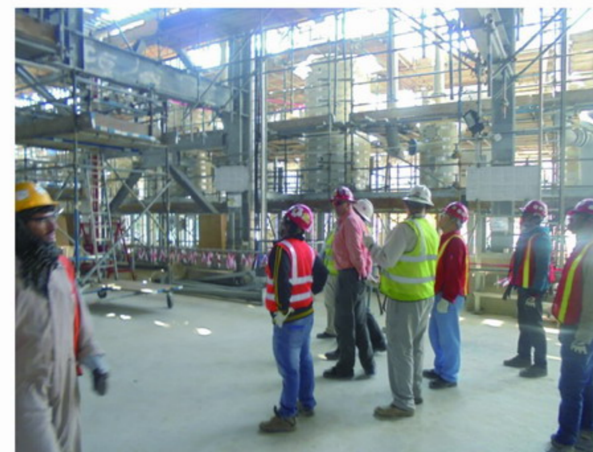
(周六业主、管理公司、施工单位安全联合巡检)
