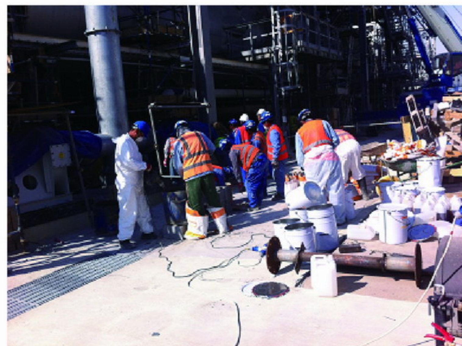
(灌浆作业时作业人员劳保齐全、同时做好文明施工)
