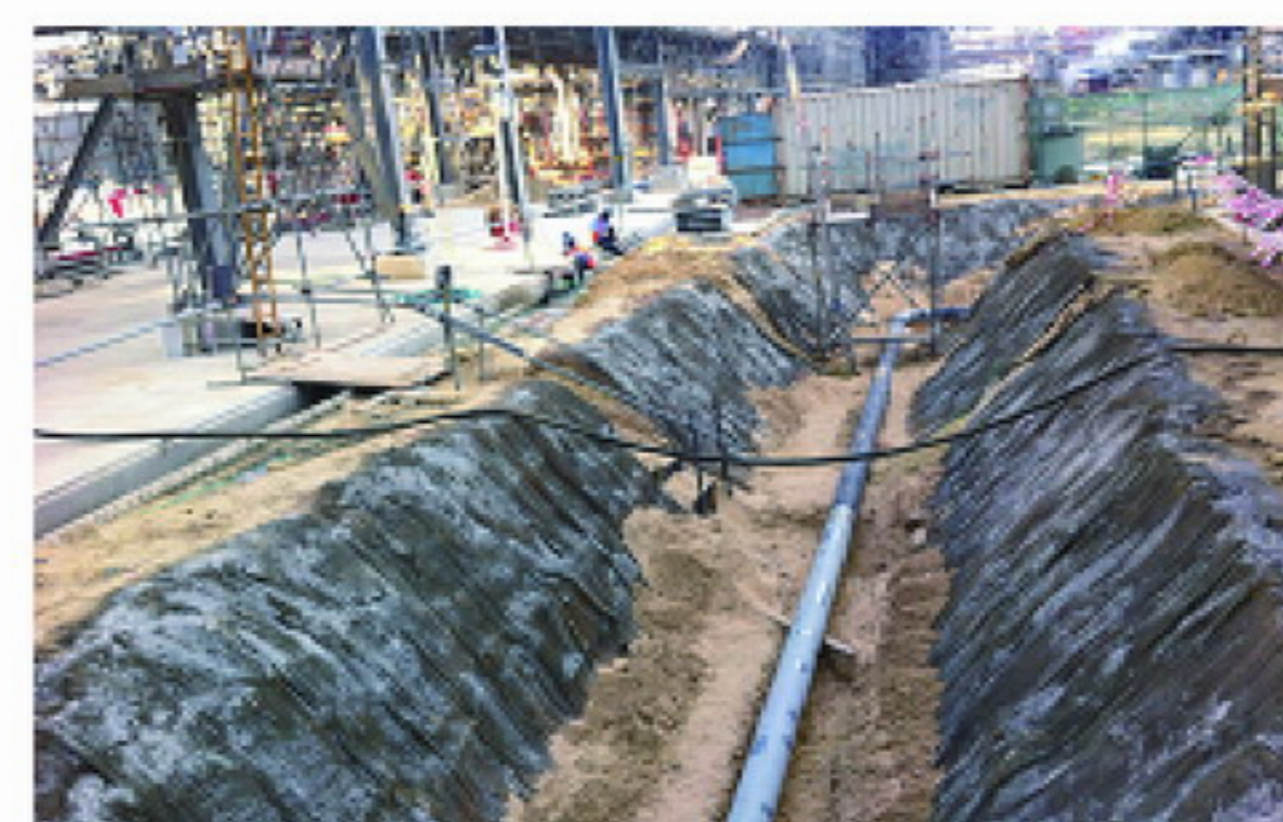
(水沟两边做护坡,设置安全通道与钢管维护)
