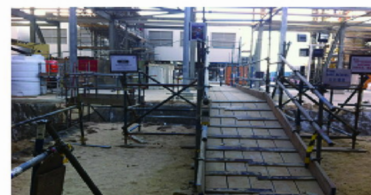
(水沟开挖后做上安全通道,保持现场畅通)
