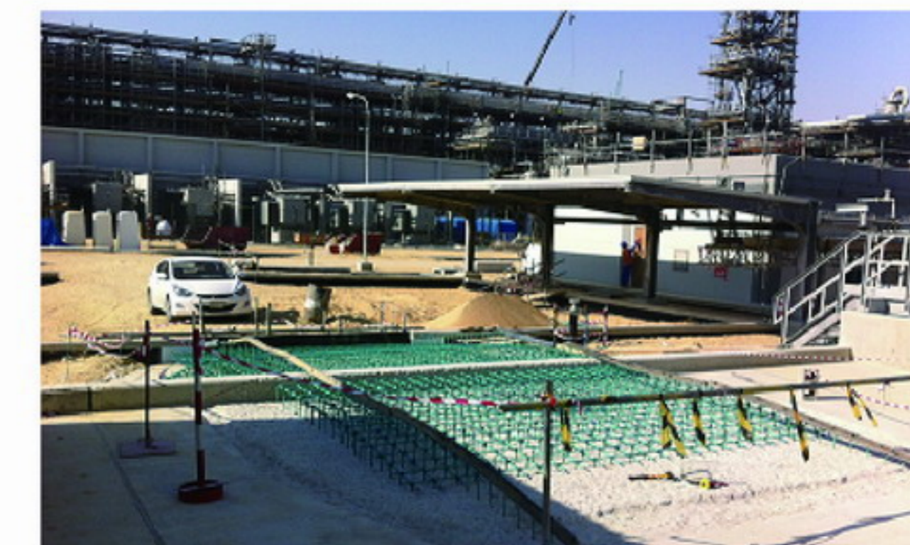
(露出的钢筋头用塑料条保护,四周做好围挡)
