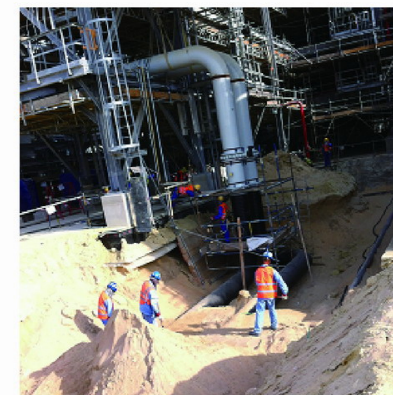
(水沟内受限空间作业)
