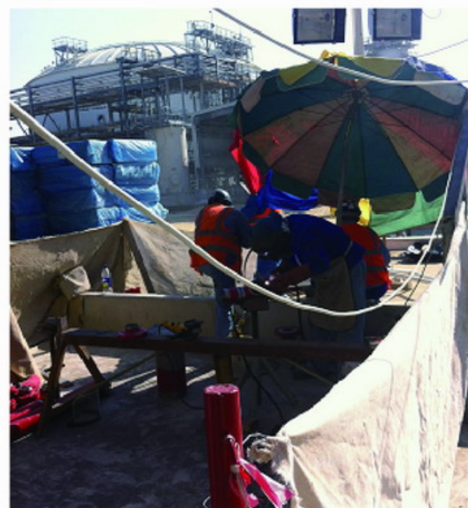
(焊接作业安全防护做得到位)
